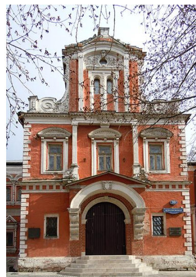
Историческое здание Института - Палаты Аверкия Кириллова в Берсеневке. 2021 г.
